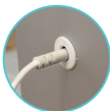
Zabezpieczone wyjście na kabel
